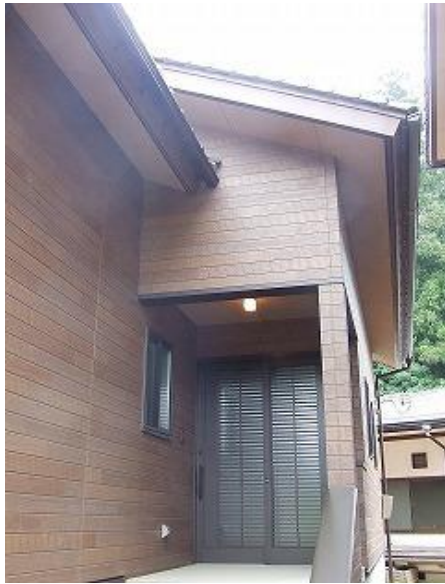
神殿棟：玄関 神殿棟の入口には引違い戸を取付け、バリアフリーに心がけました。
