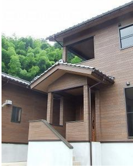
住宅棟：外観 木目調のサイディングを貼り、落ち着いた住宅に仕上がりました。 基礎は、水害の対策として高基礎になっています。
