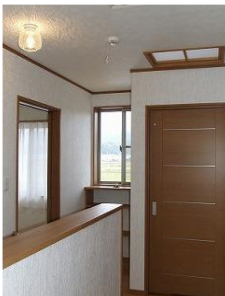
2階ホール 階段に光が差し込むように窓を取り付け、暗くなりがちな廊下に天窓からのやわらかな光が注ぎます。 窓下のデスクスペースには、読書好きのご主人様にと本棚を取り付けました。
