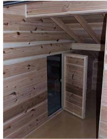
クローゼット内部 寝室横のクローゼットには、屋根裏(下屋部)点検の入口を設けました。 工事後のメンテナンスも、万全です！
