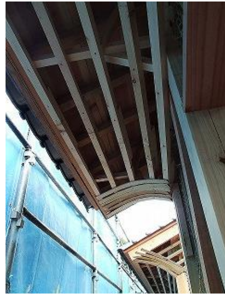
アールになった軒天井（施工中） 蔵をイメージして、建物の軒裏をアールにしてみました。 ちょっとした造作が建物をより一層魅力的なものにしてくれます。
