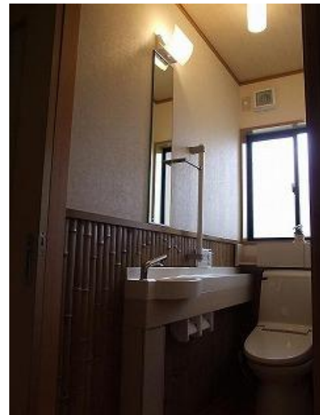
トイレ トイレ腰壁にはゴマ竹を使用しました。 長居したくなる落ち着いた空間です。
