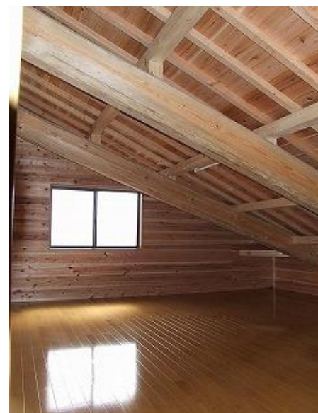
小屋裏収納 ガレージ上に造った小屋裏収納は、大容量の収納が可能です！
